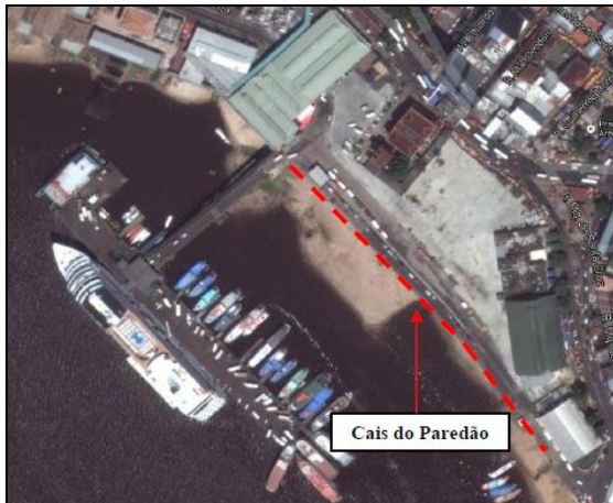
Figura 6 – Instalação fixa de acostagem, Cais do Paredão, na Área 01.
