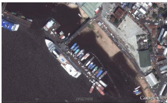
Figura 9 – Faces de atracação do Roadway.
