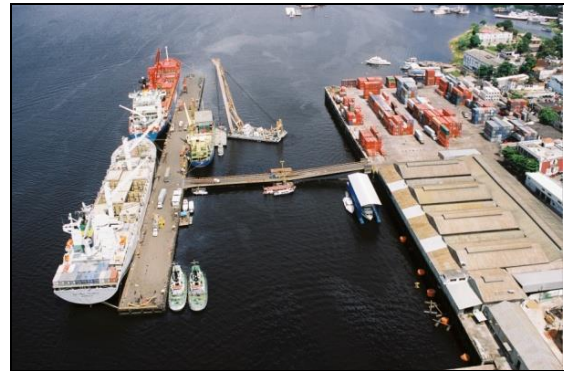
Figura 7 – Vista aérea do Cais das Torres.
