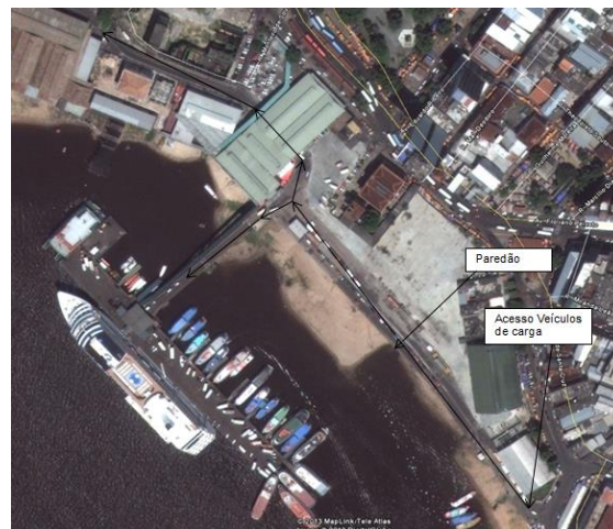
Figura 4 – Cais Roadway e via de acesso de veículos de carga. Fonte: Google Earth (2013).
