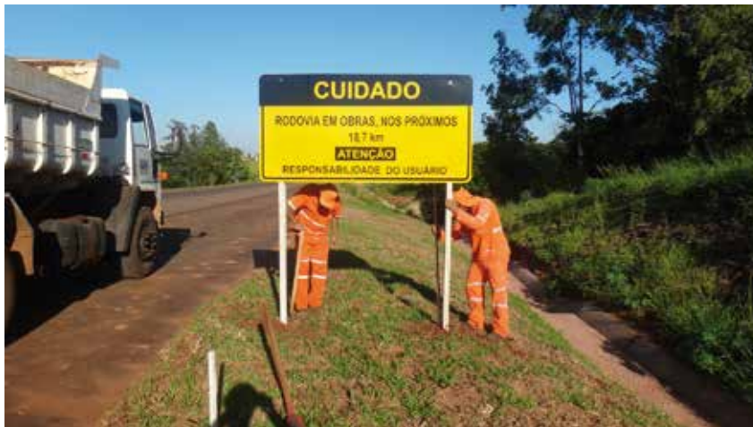
Sinalização de aviso de obras.
