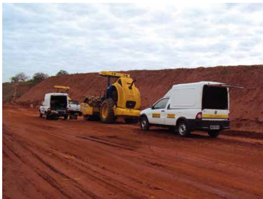
Manutenção do rolo compactador na frente de obras.
