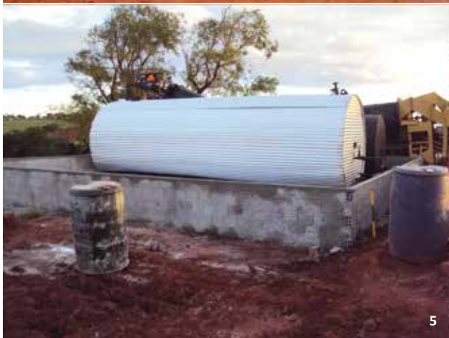
1 e 2. Bacia de contenção de vazamentos na área da usina de asfalto | 3. Reabastecimento do caminhão comboio na frente de obras | 4. Treinamento de combate ao fogo | 5. Bacia de contenção de líquidos construída junto aos tanques de emulsão asfáltica | 6. Identificação do tanque de óleo combustível.
