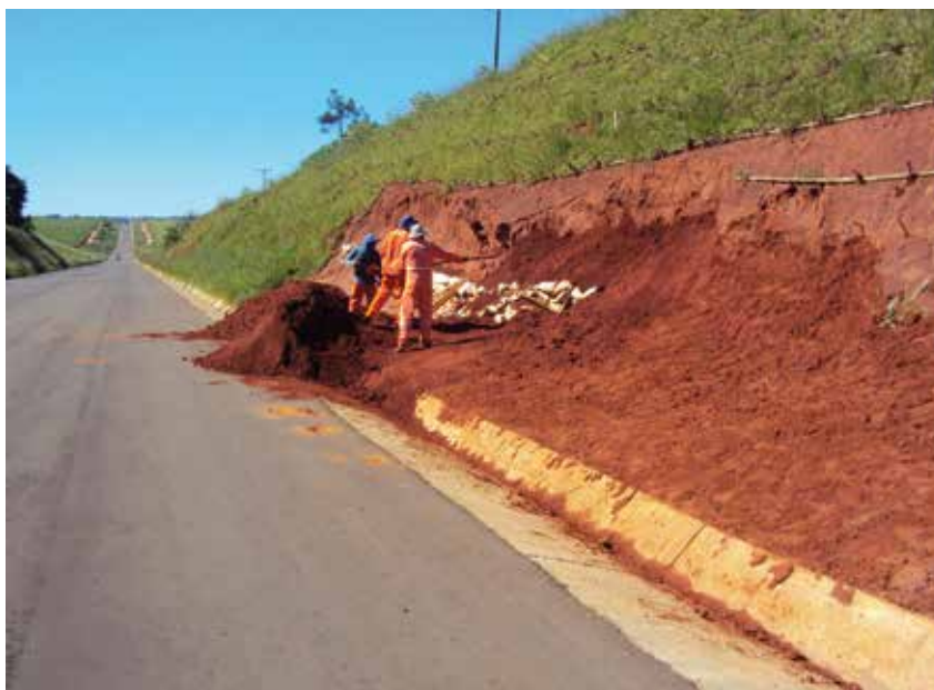
Recuperação ambiental de processo erosivo.
