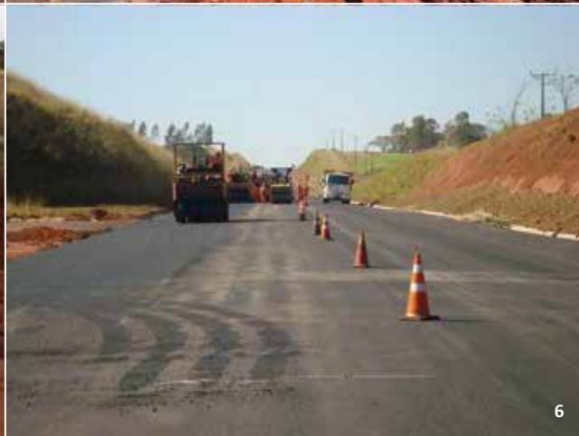
1 e 2. Sinalização no entroncamento da BR-487/PR com a PR-323 | 3. Utilização de cones e tela para interdição do fluxo de veículos e placas indicando rota alternativa para conversão à esquerda | 4. Utilização de cones para sinalização em pontos de erosão de talude | 5. Utilização de cones para isolamento da área com serviços em andamento | 6. Cones para sinalização do local onde há máquinas na pista.
