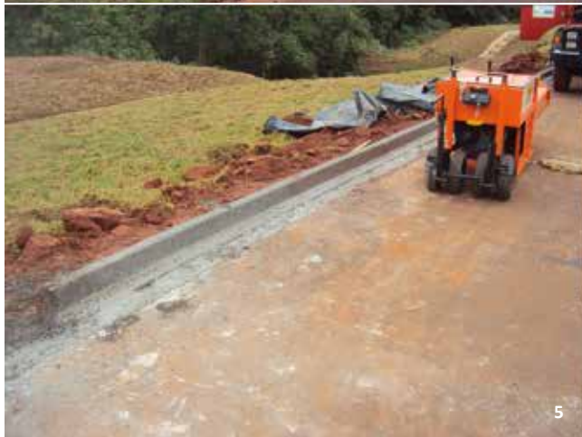
1. Valetas de proteção de aterro | 2. Valeta e sarjeta de drenagem | 3 e 4. Descida d'água em degraus | 5. Construção de meio-fio | 6. Construção de valeta de proteção de banqueta.
