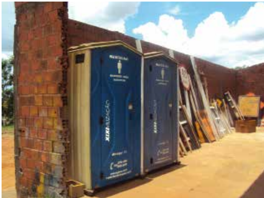
Banheiros químicos no acampamento da construtora.
