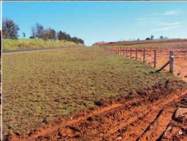
1. Descarga de solo proveniente da área de terraplenagem na interseção das rodovidas BR-487/PR e PR-323 | 2. Plantio de mudas ao longo da Área de Proteção Permanente do Rio da Areia | 3. Bota-fora de material na faixa lateral da rodovia, próximo ao Rio da Areia | 4. Retenção de águas pluviais em curva de nível. | 5 e 6. Conformação da área da jazida de solos.
