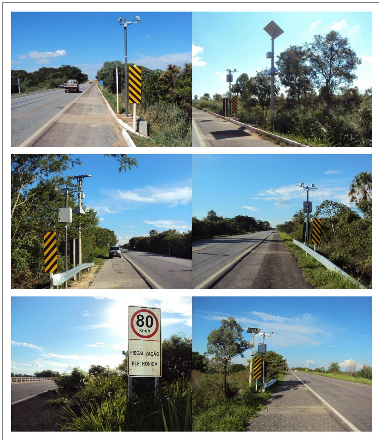
FIGURA 4 - CONTROLADORES ELETRÔNICOS DE VELOCIDADE DO TIPO FIXO INSTALADOS NA RODOVIA BR-262/MS, TRECHO DE ANASTÁCIO A CORUMBÁ
