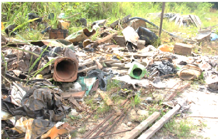
Figura 15 - Depósito de lixo na faixa de domínio na rodovia BR-174/AM.
