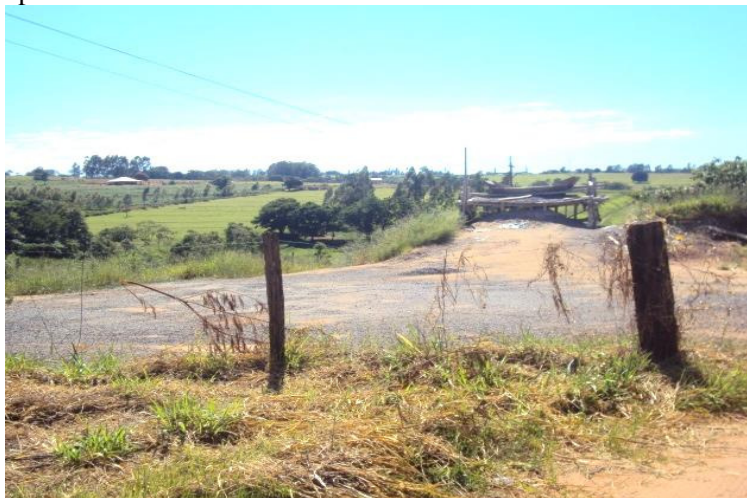
Figura 41 - Antiga usina de asfalto na rodovia BR-487/PR não recuperada.
