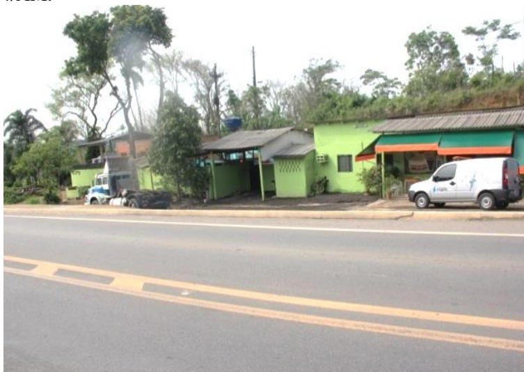
Figura 43 - Ocupação da faixa de domínio por comércio na rodovia BR-174/AM.
