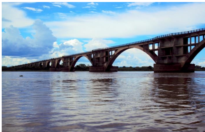
FIGURA 4.8 - PONTE FERROVIÁRIA EURICO GASPAR DUTRA FONTE: UFPR/ITTI, 2015
