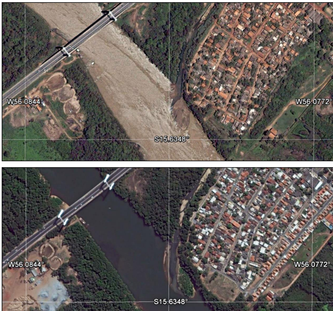
FIGURA 5.60 - ASSOREAMENTO DO RIO CUIABÁ PELA DRENAGEM URBANA EM CUIABÁ-MT, A JUSANTE DA PONTE SÉRGIO MOTTA, SITUAÇÃO EM 11-02-2004 E EM 07-04-2015.
