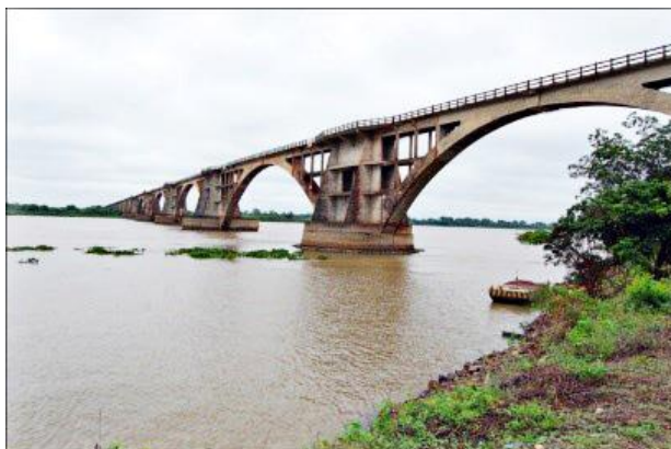
FIGURA 5.167 – PONTE PRESIDENTE DUTRA. FONTE: UFPR/ITTI, 2011.
